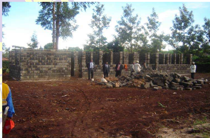
Toto je obraz priebehu výstavby nemocnice z 18.3.2007
